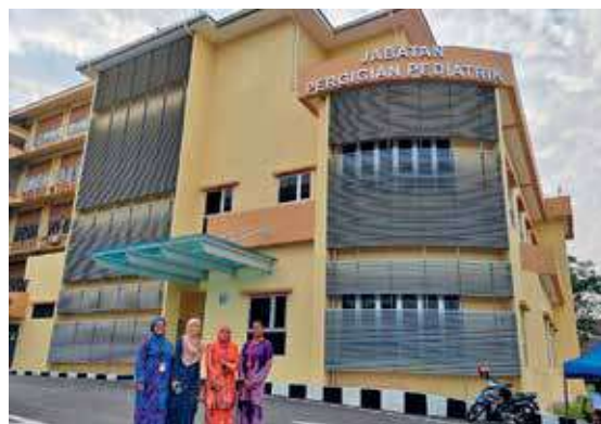
Imej 7.10 Blok Baharu di Jabatan Pergigian Pediatrik, Hospital Melaka
