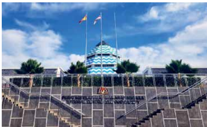
Image 9 NCFS at Bandar Baru Salak Tinggi, Sepang
