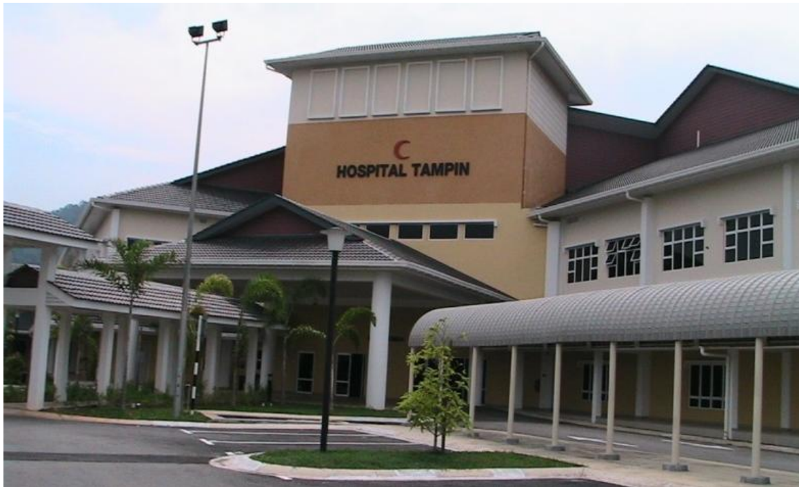
GAMBAR 4.14: BANGUNAN UTAMA HOSPITAL TAMPIN
